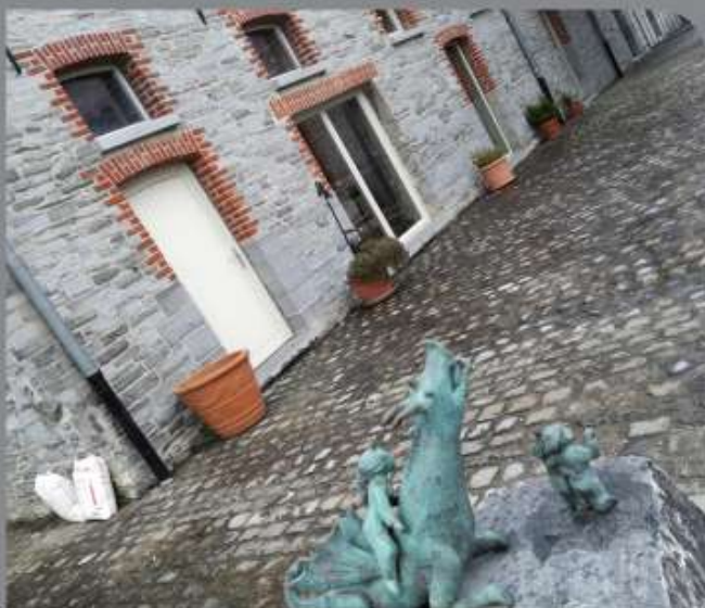
MAISON RURALE DE CALONNE Rue Albert 1 er , 14 à 7642 Calonne
